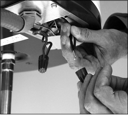
Figure 19 - Connecter les fils électriques.
