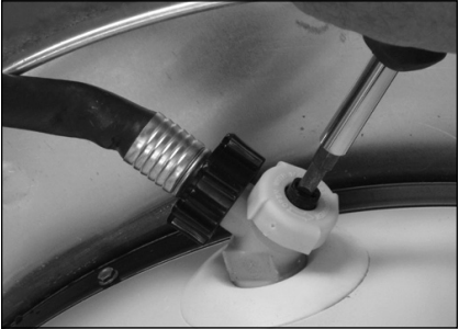
Figure 10 - Vidanger l'ancien chauffe-eau.
