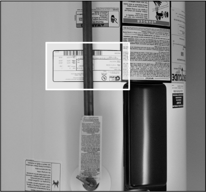
Figure 18 - Les exigences électriques du chauffe-eau peuvent être déterminées à partir de la plaque signalétique.
