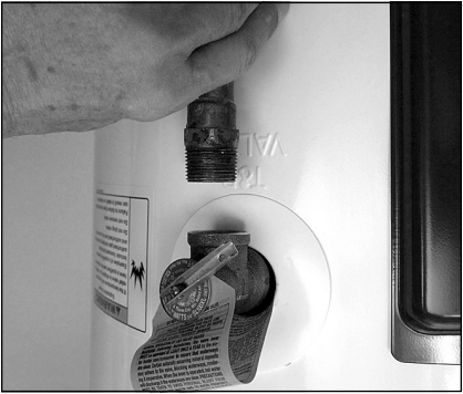
Figure 11 - Enlever le tuyau d'évacuation de la soupape de décharge DST.
