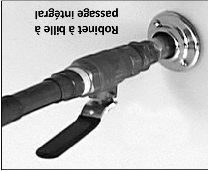
Figure 17 - Ouvrir complètement le robinet d'alimentation d'eau froide.
