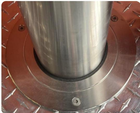
1. Retirez le collier de retenue fixé à l'unité de logement enterrée en dévissant les 3 écrous hexagonaux dans le sens antihoraire.
